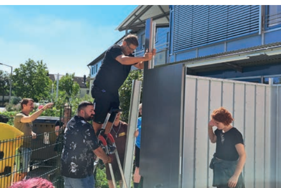
TEAMWORK: Gemeinsam war der Schuppen bald aufgestellt
